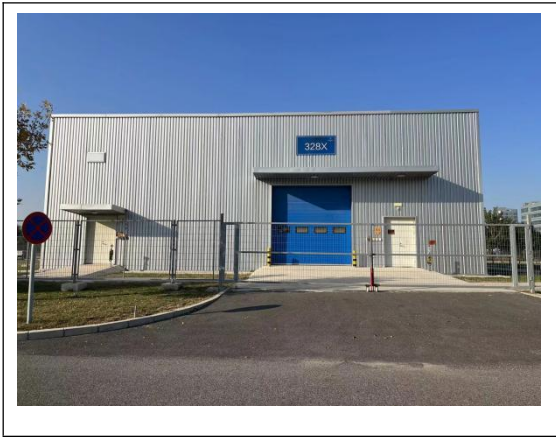
图 2-3 新建危险品区照片
