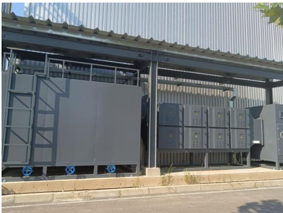
图 2-12 UV 光催化氧化器+活性炭吸附装置
